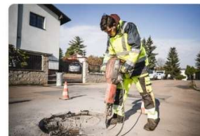
3. Vybourání okolí stávajícího rámu
