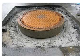
10. Výškové osazení poklopu
