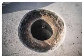
5. Vyčistění otvoru
